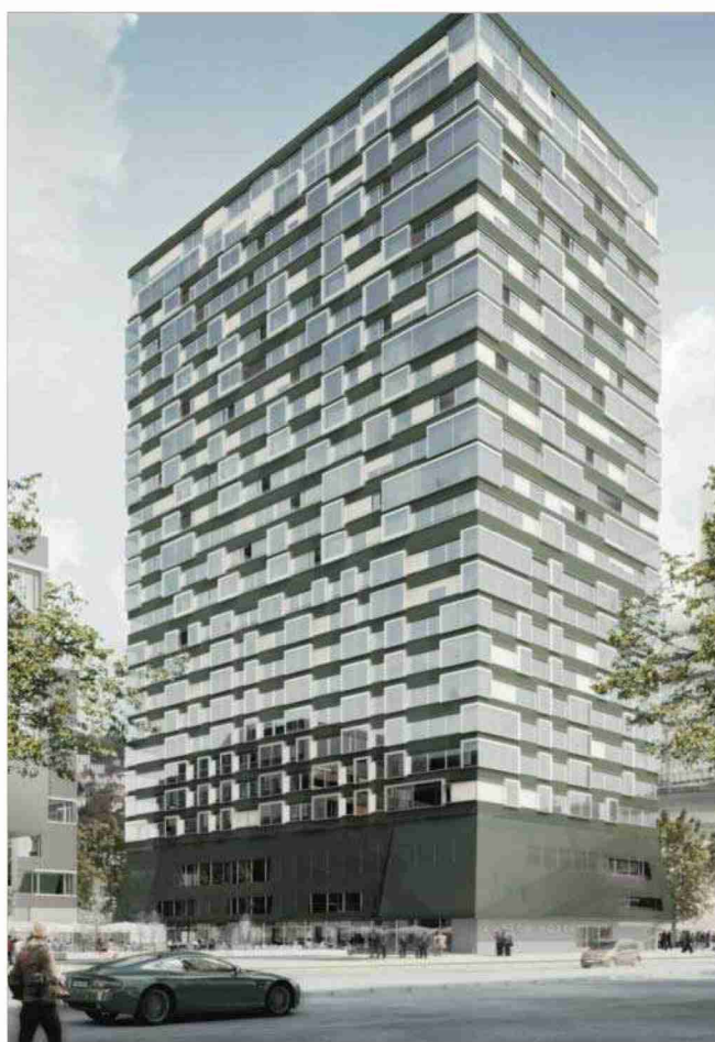
Im 80 Meter hohen Wohnturm des Hard Turm Parks ist auf den ersten 10 Stockwerken das 25hours Hotel Zürich-West integriert. Die Etagen 11 bis 24 bergen 121 exklusive Eigentumswohnungen.
